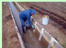
漏水箇所の目地補修等による水路の保安全管理
