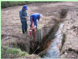
■ 点検・機能診断
