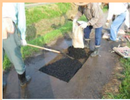
■ 農道舗装の補修
