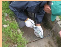
■ 水路の老朽化箇所の補修
