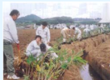
グリーンベルト設置による土壌流出防止
