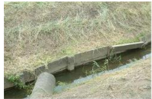
水路側壁のはらみの状況
