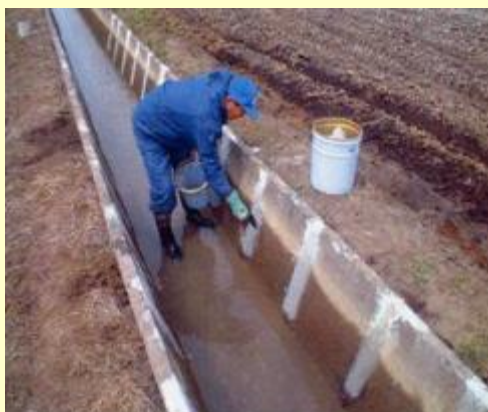
目地詰め作業
