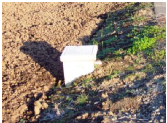
傾いた給水栓ボックス
