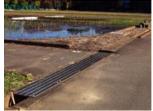
コンクリート蓋とグレーチング
