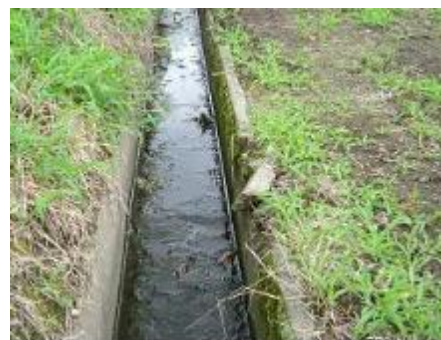
破損したU字溝
