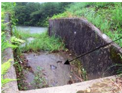
洪水吐底板（コンクリート）の欠損
