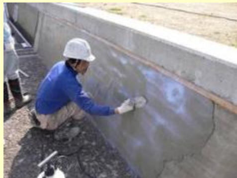
コーティング作業の状況
