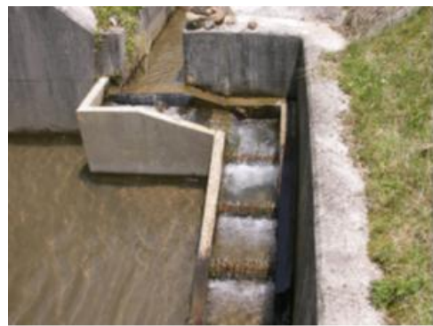
段差解消水路
