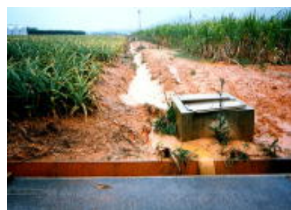
土砂の流出状況
