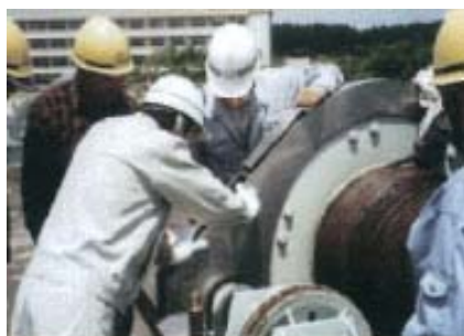
ポンプ点検状況
