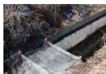
ネット設置例
