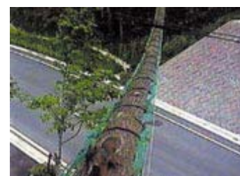
橋梁設置例 （出典：清水建設）
