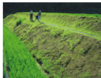
小段が設置されている法面
