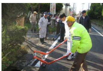
コンクリート蓋設置例
