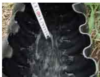
通水試験（水深確認）
