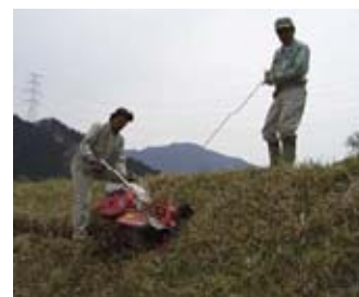
小段設置状況（掘削）
