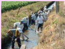
水路の泥上げ
