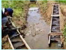
水田魚道の設置
