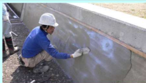
老朽化した水路壁のコーティング
