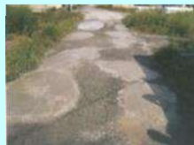
農道の窪みの補修
