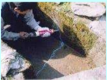
水路のひび割れ補修
