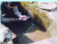
水路のひび割れ補修
