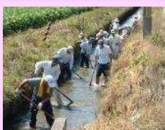
水路の泥上げ
