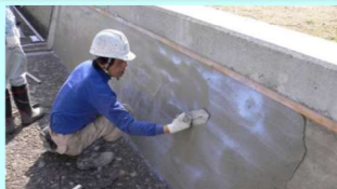
老朽化した水路壁のコーティング
