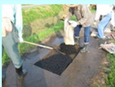
農道の部分補修
