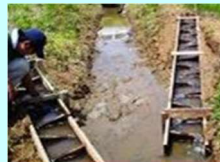
水田魚道の設置
