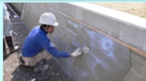
老朽化した水路壁のコーティング
