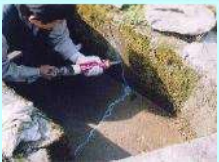
水路のひび割れ補修
