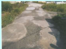
農道の窪みの補修
