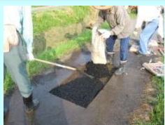
農道の部分補修
