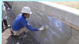
老朽化した水路壁のコーティング
