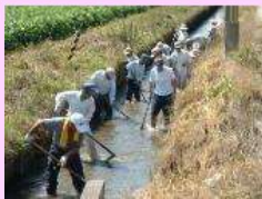
水路の泥上げ
