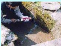
水路のひび割れ補修
