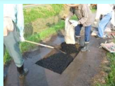
農道の部分補修
