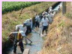
水路の泥上げ
