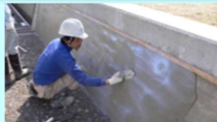
老朽化した水路壁のコーティング
