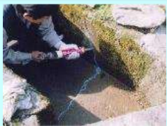
水路のひび割れ補修
