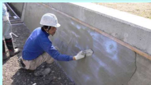
老朽化した水路壁のコーティング
