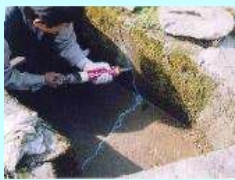
水路のひび割れ補修
