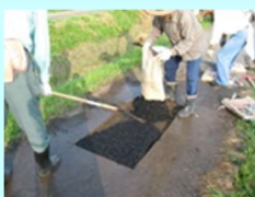
農道の部分補修
