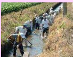
水路の泥上げ
