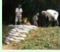
漏水箇所の補修
