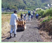
未舗装農道の舗装
