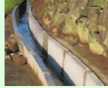
コンクリート水路の更新
