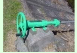
ゲート、バルブの更新
