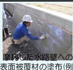
摩耗した水路壁への表面被覆材の塗布(例)
