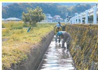
〔農家・非農家による水路の泥上げ〕
