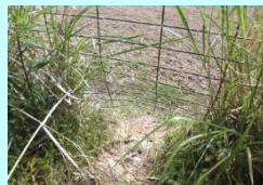
防護柵下から進入
