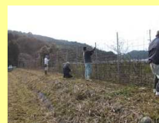
地域住民による 柵の補修
