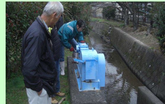
水門ゲートの点検
