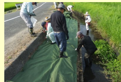
防草シート敷設
