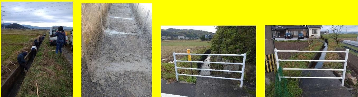
左2枚は、U字溝補修作業。右端は増水時危険な箇所に設置された転落防止柵。
