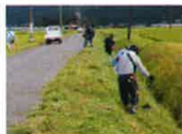
(法面の草刈り)
