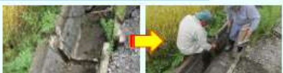
地震により破損した水路を地域共同で補修(外注も可能)
