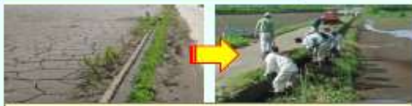
大雨により水路に堆積した土砂を地域共同で撤去(外注も可能)
