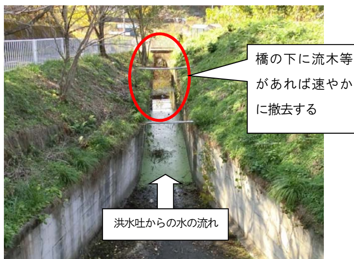
写真8：洪水吐下流水路の例
