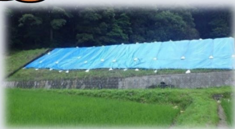
■堤体下流法面にブルーシート設置
