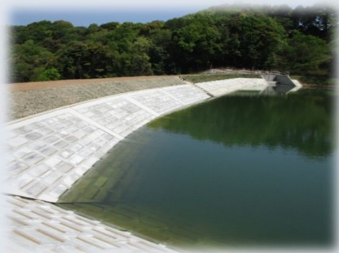
図-6-1 法面保護工（前法）
