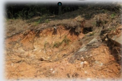
接続部の侵食
