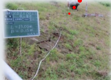
異状箇所に杭を設置
