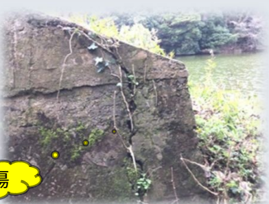
側壁の損傷
