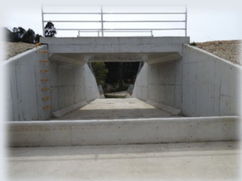
図-4-1 洪水吐き（上流側）
