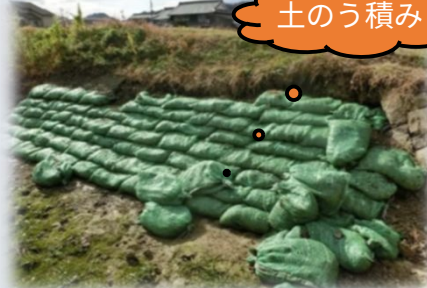
■堤体上流法面に土のう設置
