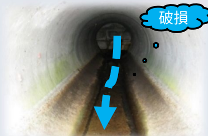
底樋管破損
