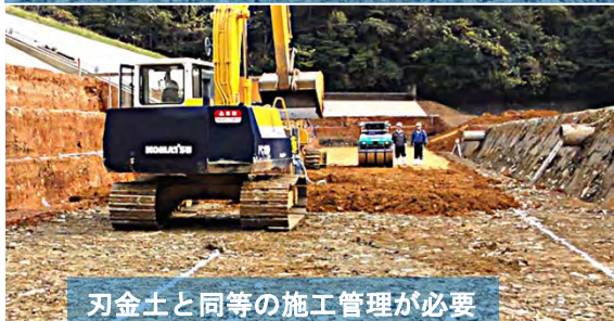
谷部に位置するため池の場合、堤体基礎部に1~2mの礫層が存在することが多い
