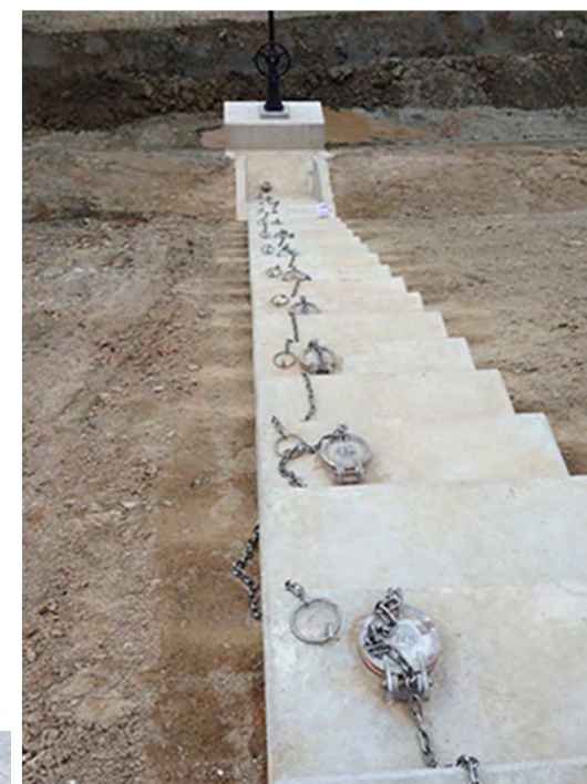
堤体設置斜樋（ため池栓）
