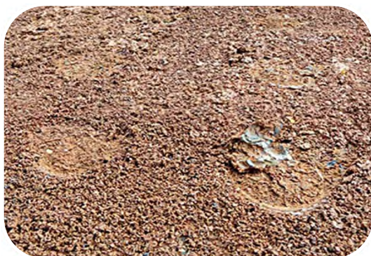
良好な刃金土の転圧状況
