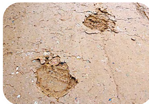
不良な刃金土の転圧状況
