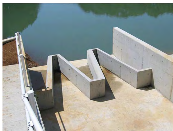
ラビリンス堰（コンクリート製）
