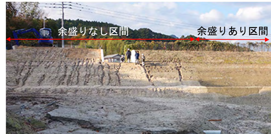
刃金土+鞆土の同時施工事例
