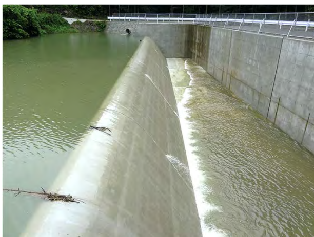
側溝型洪水吐
