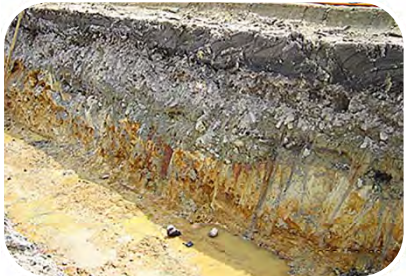
トレンチ基礎部は地山部に入れ込む
