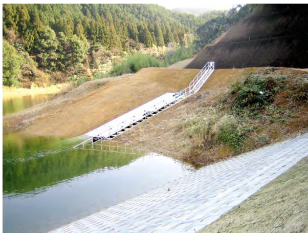
地山設置斜樋（遠景）
