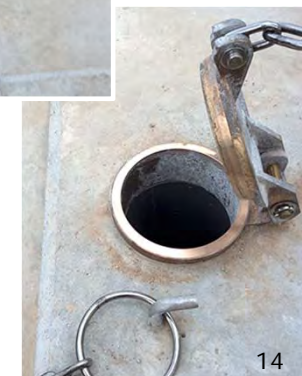
堤体設置斜樋（ため池栓）
