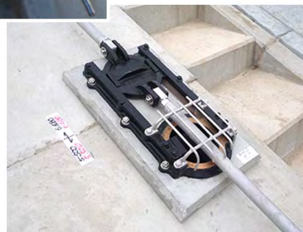
堤体設置斜樋（ゲート）
