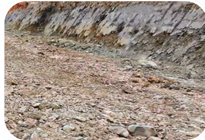
礫層が残った基礎部
