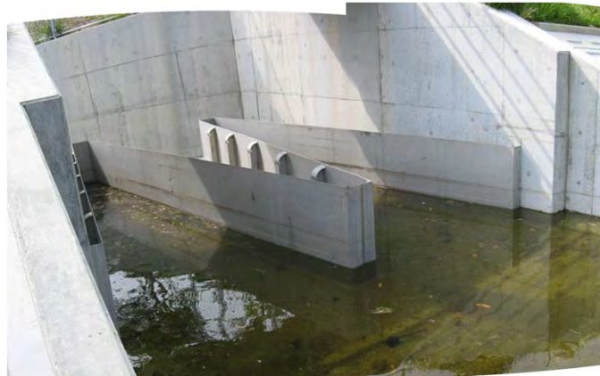
ラビリンス堰（ステンレス製）
