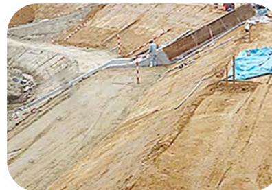
刃金土の施工を先行した事例
