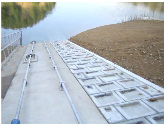
地山設置斜樋（近景）
