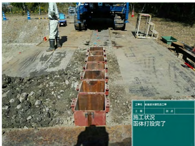
函体打設完了
