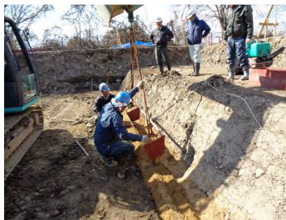
型枠引き抜き
