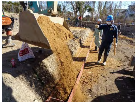
型枠内にベントナイト混合土投入
