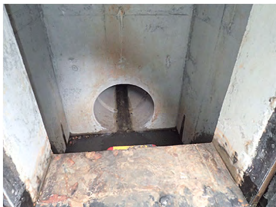
土砂吐部 ゲート部から底樋部を望む
