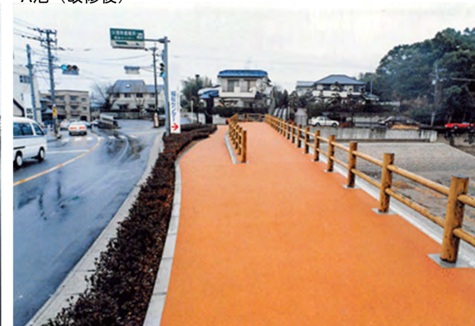
A池（改修後）
