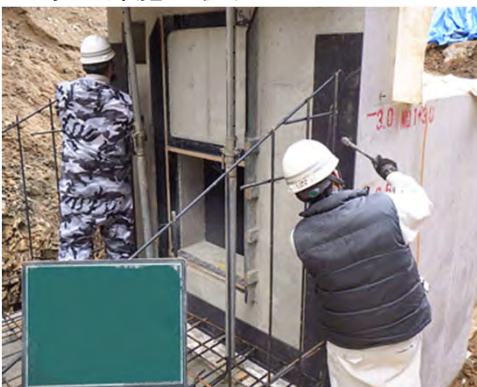
土砂吐部施工状況
