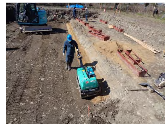
ベントナイト混合土層と抱き土を同時転圧
