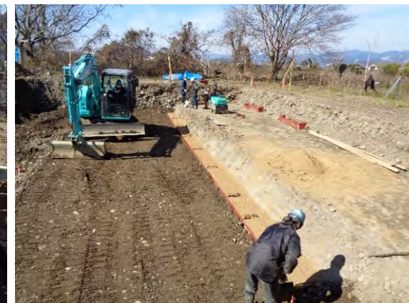
抱き土撒き出し
