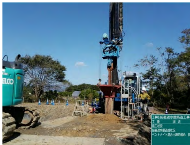
ベントナイト混合土遮水壁 造成
