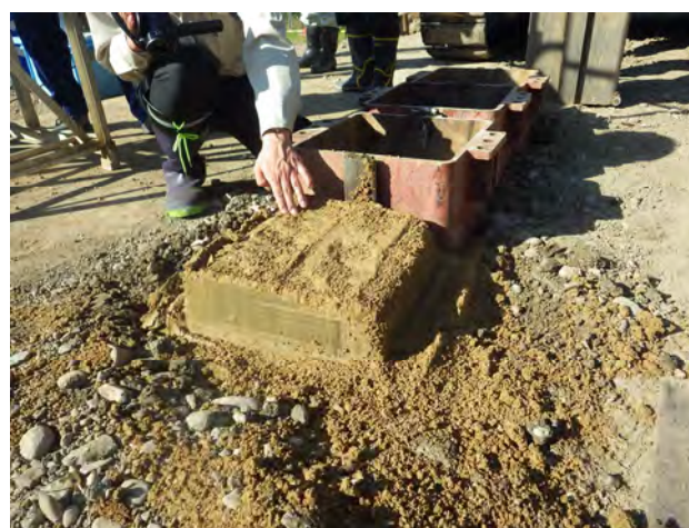
ベントナイト混合土鉛直遮水壁 杭頭部確認
