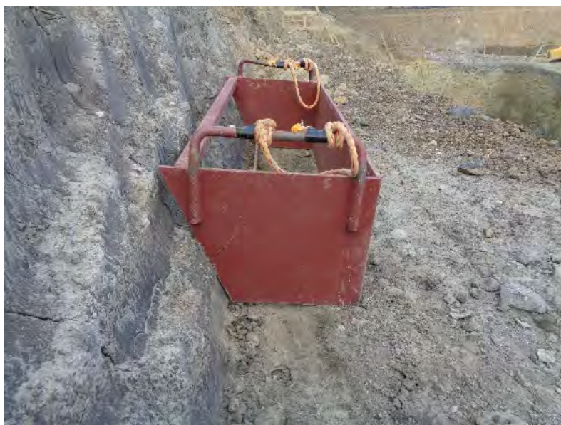
ベントナイト混合土投入用型枠
