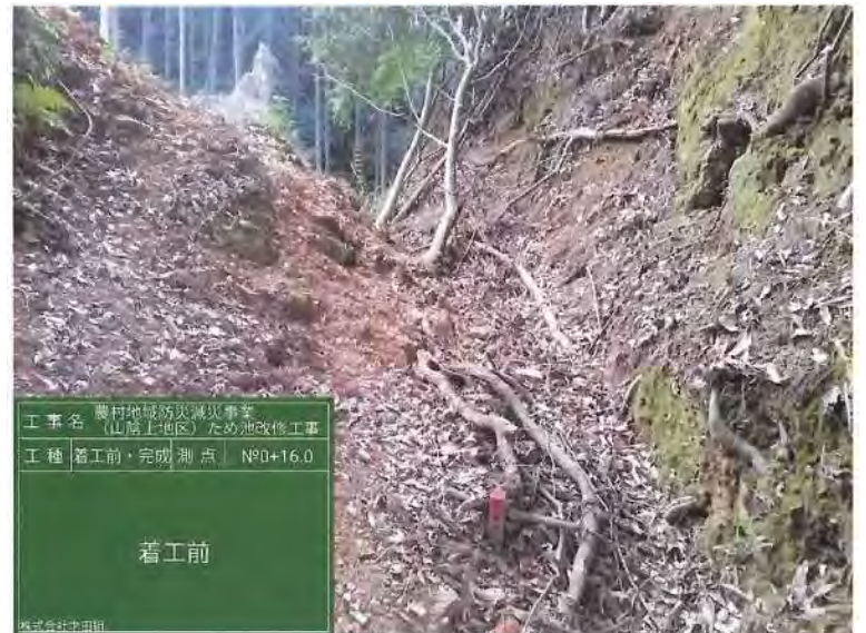
洪水吐下流水路を撮影
