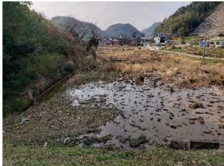
堤体から下流側を撮影
