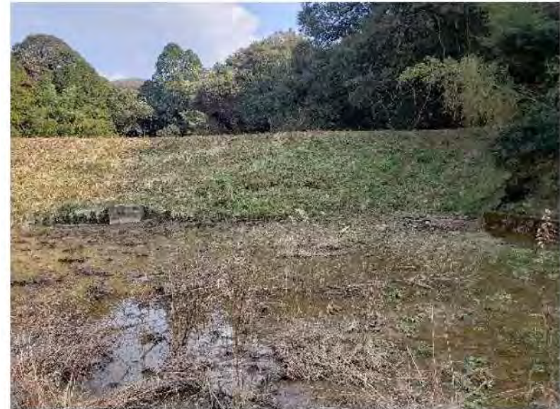
堤体の下流側から撮影
