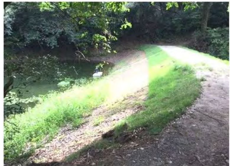
堤頂部を撮影
