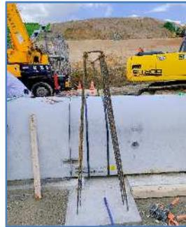
水膨潤ゴムを2重で配置し現場打ちコンクリートを打設
