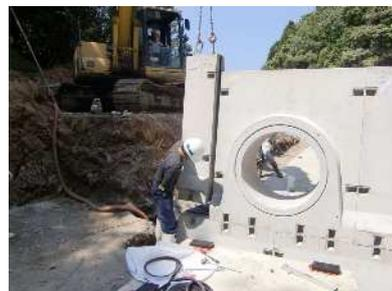
Pca底樋管と同様の接続構造のため、一体性がよく、
