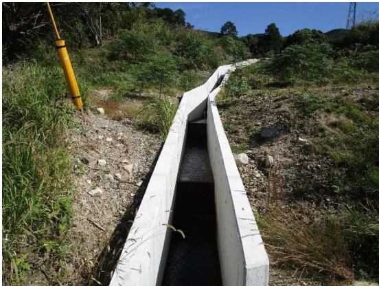
繋ぎ込み部分を撮影
