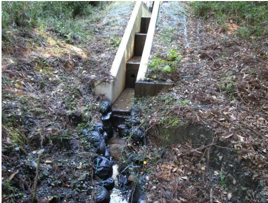
繋ぎ込み部分を撮影
