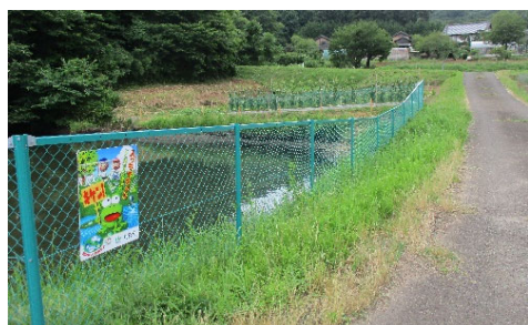
ネットフェンスの設置状況
