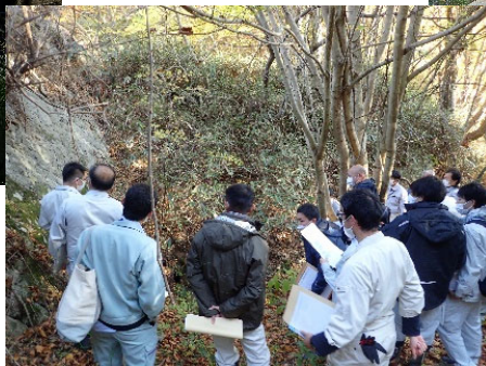
ため池の漏水の有無の確認
