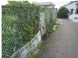
金網による応急措置の状況
