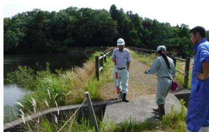
ため池の点検の状況
