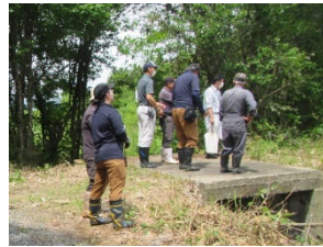
緊急点検の実施状況
