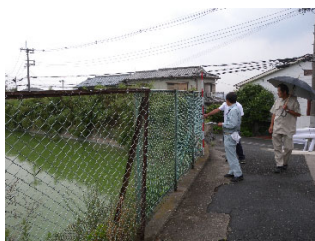
安全柵の点検状況
