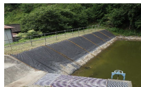
救助ネットの設置状況
