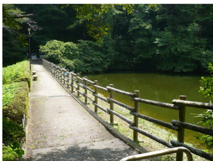
転落防止柵の設置状況
