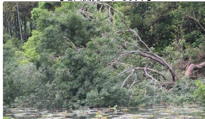
【地山法面の崩壊による倒木・土砂流入】
