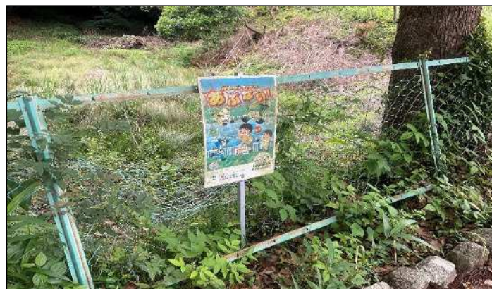
【フェンスの転倒・破れ】
