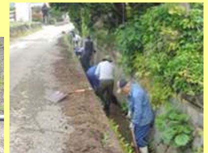
水路の泥上げ
