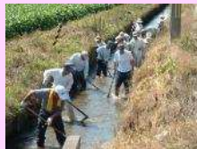
水路の泥上げ
