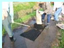
農道の部分補修
