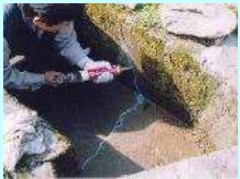
水路のひび割れ補修
