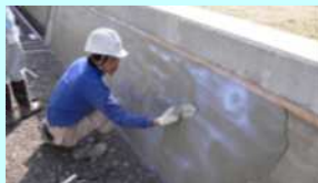
老朽化した水路壁のコーティング
