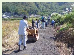
未舗装農道の舗装
