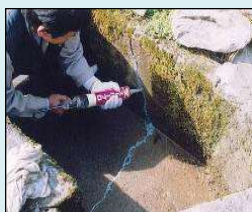
ひび割れの補修
