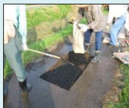
農道の部分補修
