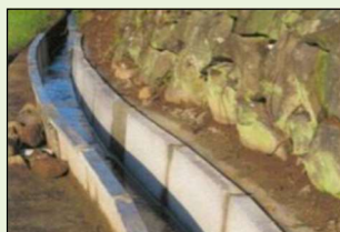
素堀り水路からの更新
