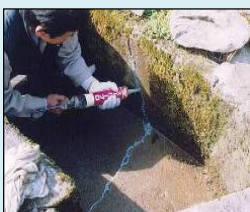
ひび割れの補修
