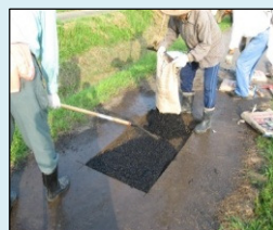
農道の部分補修
