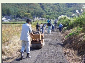
未舗装農道の舗装
