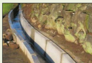
素堀り水路からの更新
