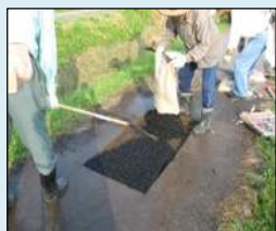
農道の部分補修
