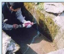
ひび割れの補修
