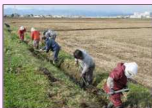
水路の泥上げ
