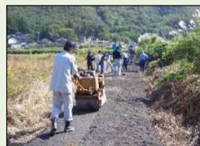
未舗装農道の舗装
